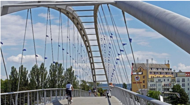
Foto: Dreiländerbrücke Weil am Rhein
